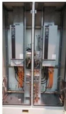
Kompressordrivningar + elnätsanslutning
